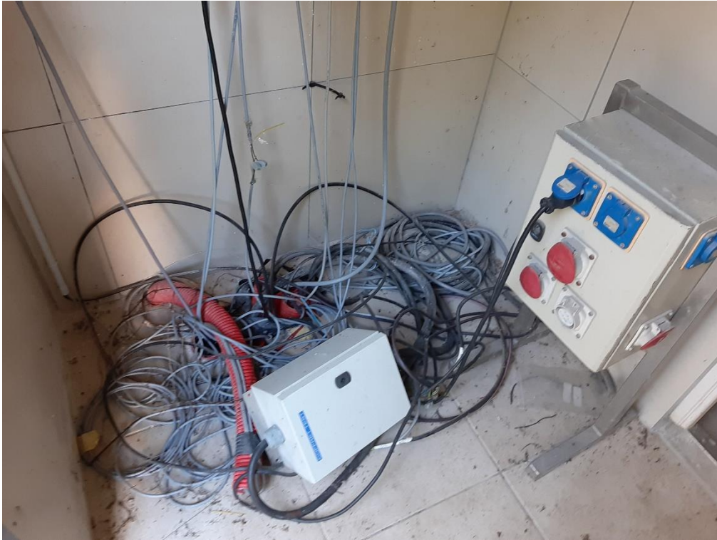
Vue de l'état actuel à l'entrée du local Harmonie le 15/10/2020
