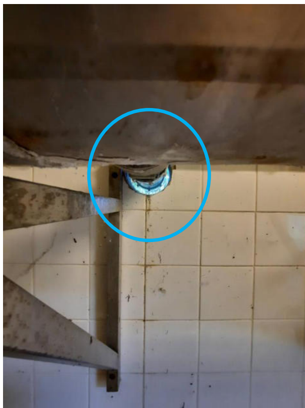
Vue de détail de l'espace à obturer sur le local Mélodie
