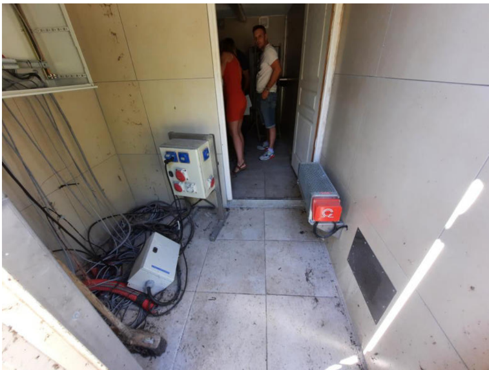
Vue intérieure du local Harmonie (entrée)
