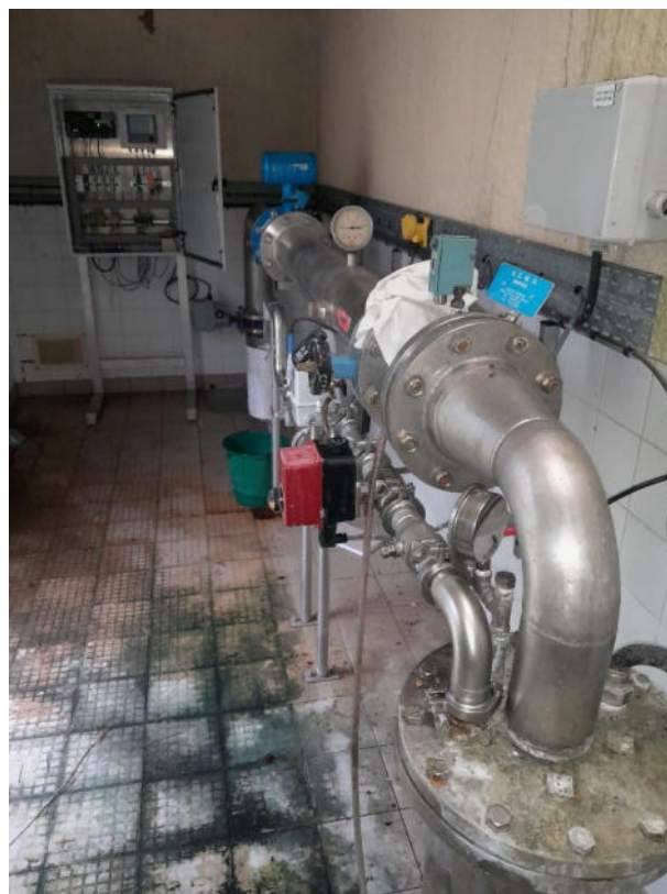
Vue de la tête de puits et de la manchette de mesure
