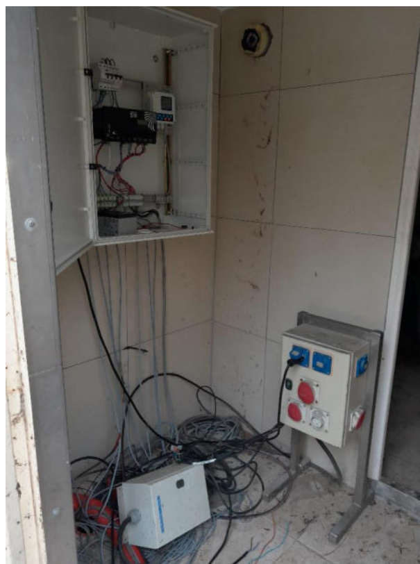
Vue de l'état actuel à l'entrée du local d'Harmonie
