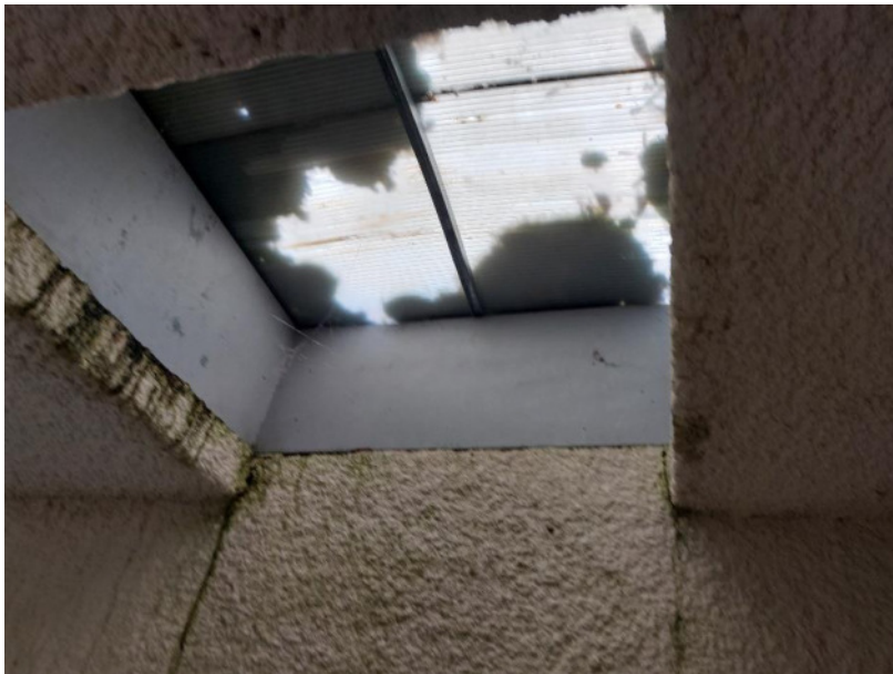
Vue état du skydome
