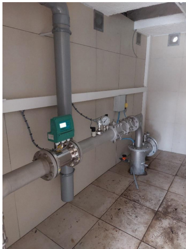
Vue de la tête de puits
