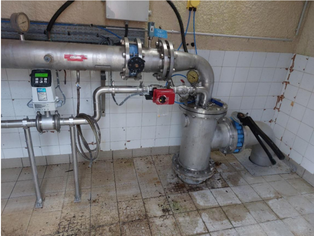
Vue de la tête de puits
