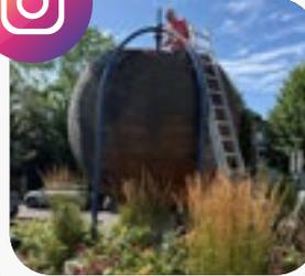
Le Globe installé en 2000 lors du Téléthon a bénéficié d'une rénovation. Le chantier s'est déroulé en plusieurs étapes : remplacement de 6 rangs de bois en chêne, ponçage complet et peinture, repeinte des continents à l'identique, repeinte de la structure béton et des éléments métalliques.
